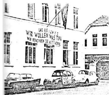
Am Sonntagabend betrat eine Abordnung der Naturfreundejugend Bremen Nord das ehemalige Werk III der Steingutfabrik. Erste Renovierungsarbeiten wurden gemacht, um das Projekt „alte Fabrik“ zu realisieren. Am Montagmorgen will die Naturfreundejugend dem Liegenschaftsamt einen Vorvertrag zur Überlassung vorlegen.
